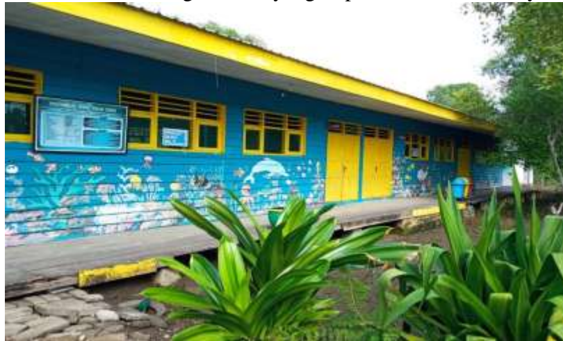
Gambar 5. Gedung sekolah yang terpakai terbuat dari kayu
